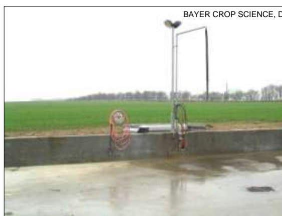
Rys. 13 W gospodarstwie ciecz użytkową należy sporządzać na nieprzepuszczalnym podłożu, umożliwiającym zbieranie skażonej wody
